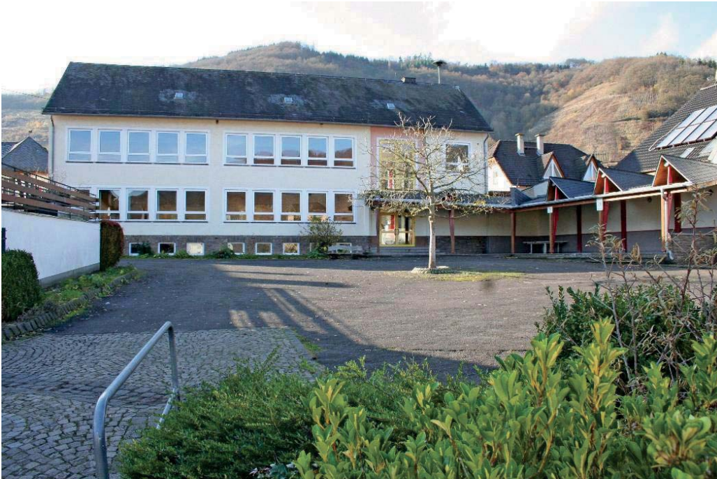
Abbildung 8-13: Ehemalige Grundschule Bremm
